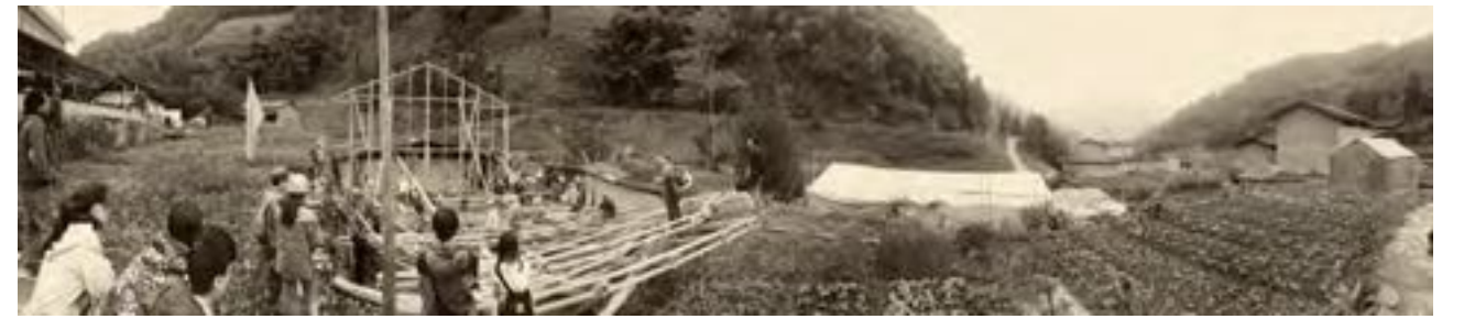
四川雅安 “盖房子”现场 2013年
